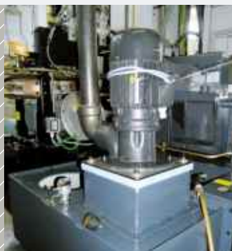
Izolacja pompy za pomocą tworzyw Sylomer® i Sylodyn®
