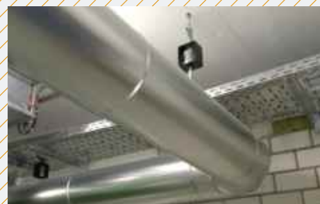
Przewody rurowe izolowane za pomocą izolatorów Isotop® SD/Z
