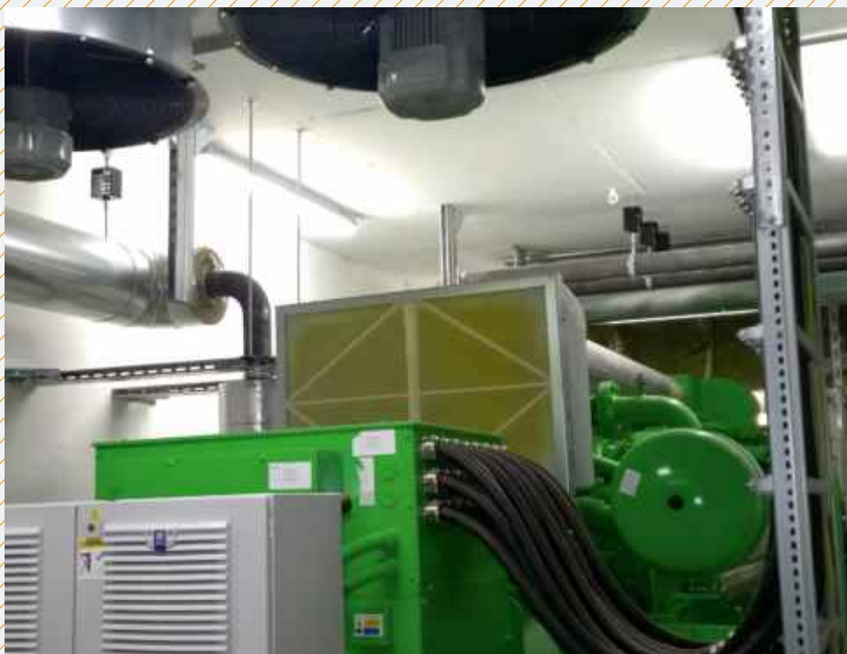
Przewody rurowe izolowane za pomocą izolatorów Isotop® SD/Z
