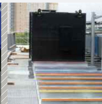
Posadowienie pasmowe na tworzywie Sylomer®
