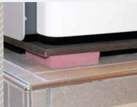
Tłumienie wtórnego dźwięku powietrznego poprzez sprężyste odizolowanie instalacji
